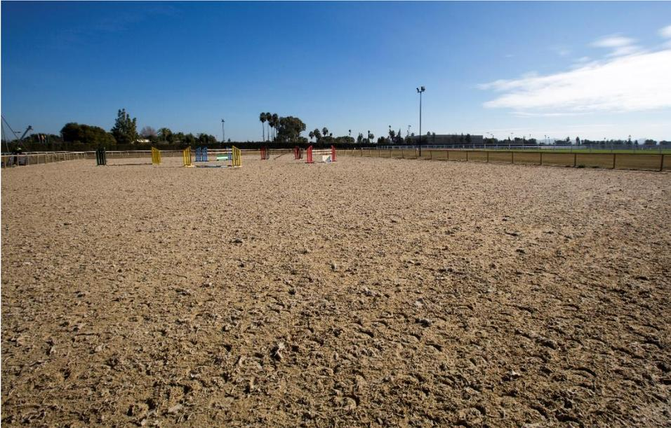
**C) Pista de Calentamiento:** Dimensiones 63 x 63 mts. Pista de arena de sílice y geotextil. Riego por el sistema de flujo y reflujo.
