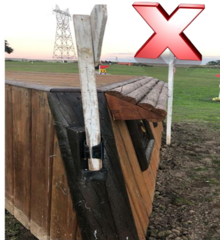
Un mal ejemplo de un obstáculo con un faldón ascendente a 45º sin cerrar el hueco creado y con el riesgo de que un caballo se enganche una mano en su trayectoria ascendente de salto
