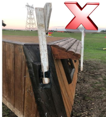
Un mal ejemplo de un obstáculo con un faldón ascendente a 45° sin cerrar el hueco creado y con el riesgo de que un caballo se enganche una mano en su trayectoria ascendente de salto
